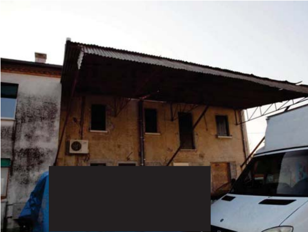
foto 7 tettoia vista da est
