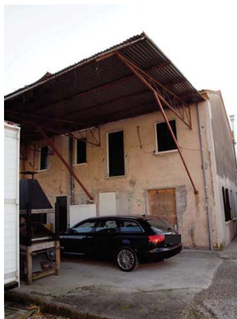
foto 6 tettoia vista da nord
