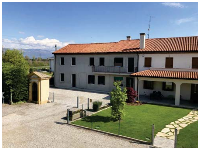
foto 1 vista esterna da sud
